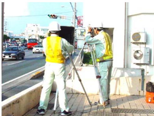
電子平板測量状況
